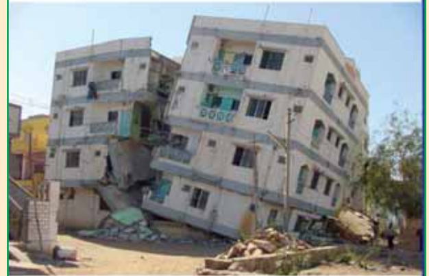
ख) सन् 2001 में भुज (भारत) में आए भूकंप के दौरान प्रबलित कंक्रीट वाले कॉलमों (और भवनों) का ध्वस्त होना
